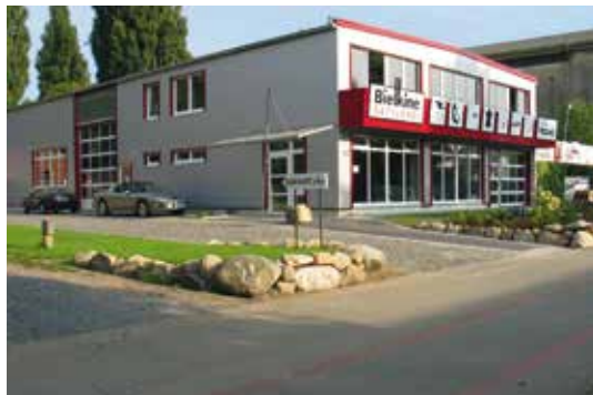
Hallenansicht von Außen
