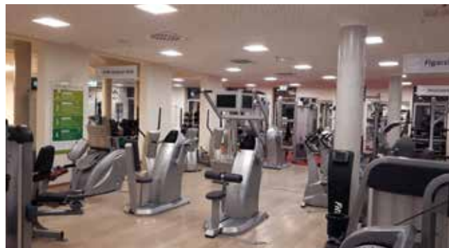
Die Trainingsfläche wird energieeffizient in LED erleuchtet
