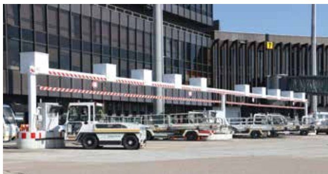
Ladebrücke für Elektromobile
