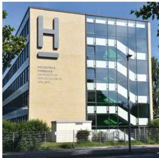
Westfassade Gebäude 1A Ricklinger Stadtweg 120
