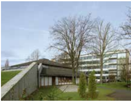
Bibliothek und Südfassade Gebäude 1A
