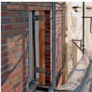
Dicke mineralische Dämmung hinter der neuen Klinkerfassade.
