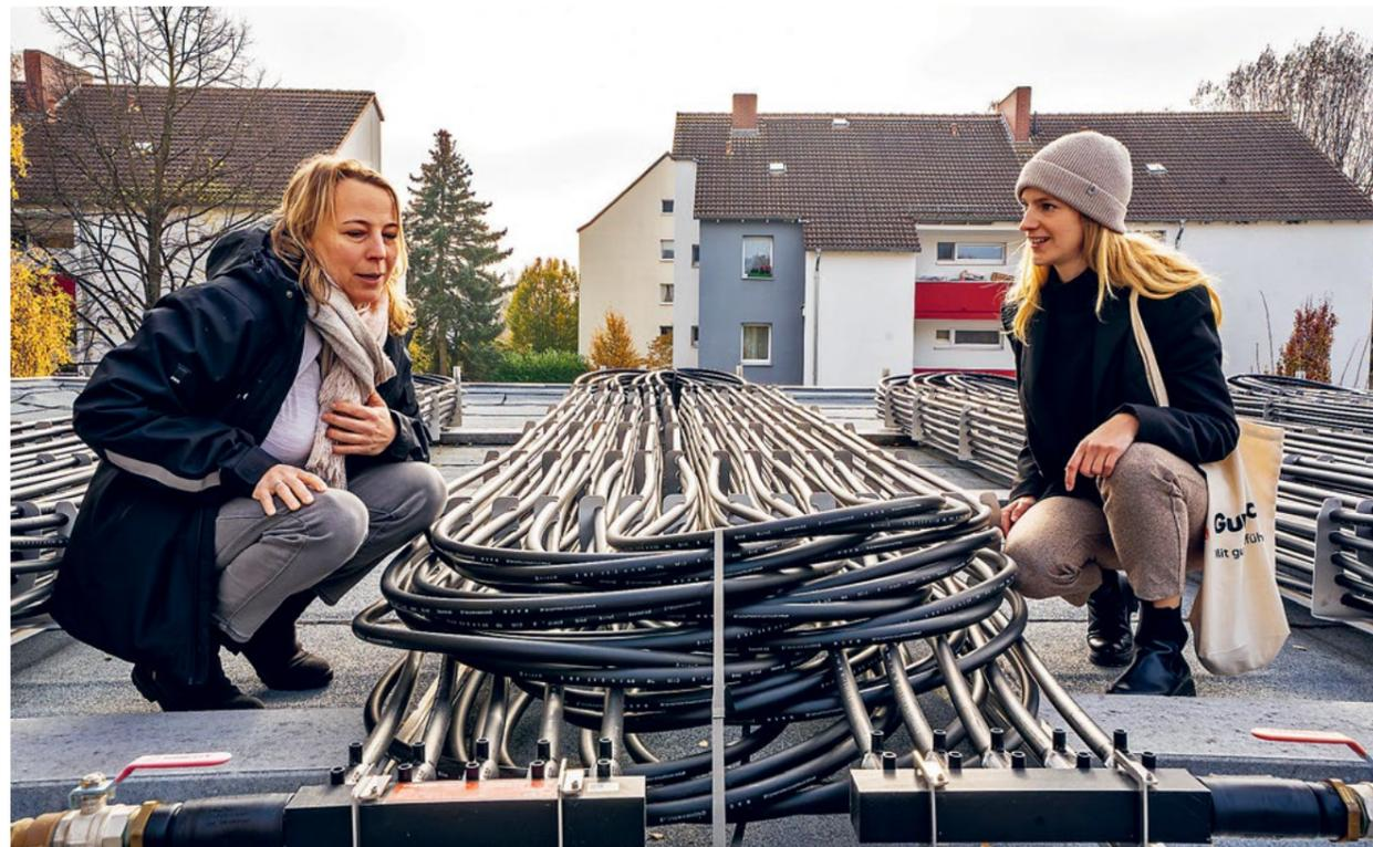
Gundlachs Ökologiebeauftragte, die Architektin Corinna Stubendorff und Clara Marie Ritter, beide vom Gundlach-Team Bestandsentwicklung auf der Baustelle: In Ahlem entsteht ein Quartier-Nahwärmenetz für rund 100 Wohnungen mit Erd-Wärmepumpe, Blockheizkraftwerk und Spitzenlastkessel.
