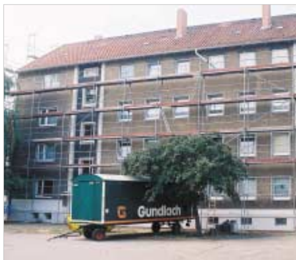
... schnell ist die gesamte Fassade eingerüstet, erste Dämmelemente kleiden bereits das Kellergeschoss ein ...
