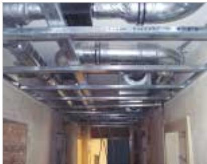
Modernste Lüftungstechnik geschickt verpackt: Die Decken der Wohnungsflure wurden einfach abgehängt.
