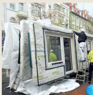
Hannover: Die Elemente werden komplett mit Fenstern und Türen angeliefert.
