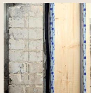
19 Zentimeter Holzspänedämmung in Holzwandfertigteilen hüllen das Haus warm ein.
