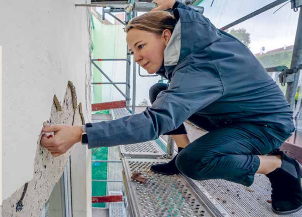
Corinna Stubendorff – Architektin bei Gundlach – überprüft die Bausubstanz an einem Gebäude in der Calenberger Neustadt.
